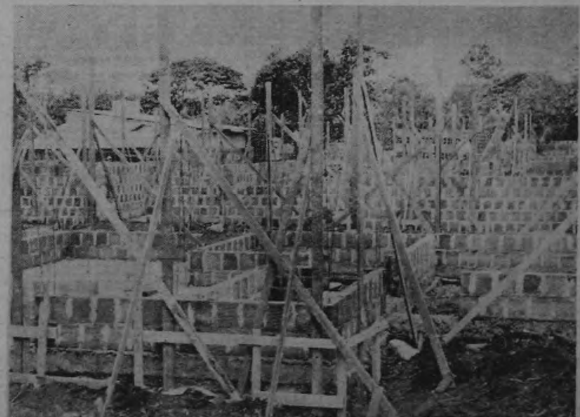
CONSTRUCCION DE VIVIENDAS POPULARES EN LA UNIDAD VECINAL DE HATILLO.— Se aprecia en la gráfica un aspecto de la construcción de viviendas populares en la Unidad Vecinal de Hatillo, construidas por el INVU. Las viviendas son sólidas, resistentes y cómodas. Los estudios sociales de los solicitantes de estas viviendas se iniciarán en julio.
